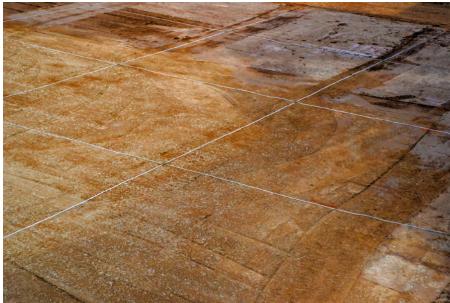
Bild 3 Vermaschter Ringerder unterhalb der Fundamentplatte.
